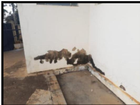
Item 03 - Paredes e laje internas (corredores, consultórios e farmácia) trincadas e com pinturas desgastadas, descascadas e com sinais de infiltrações (fotos 47/60):
